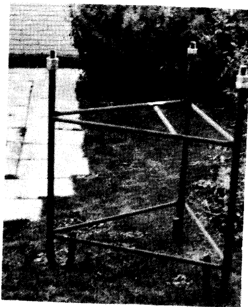
Foto 1. Dit is het zogenaamde kader, dat met de mast wordt meegeleverd. Het wordt ingestort in de beton.
